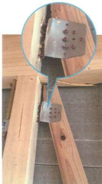
筋交い用補強金物ビス抜け
